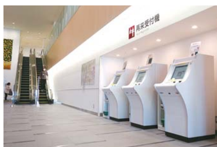
再来受付自動発行機は壁面と調和の取れた色で納入(3台)
